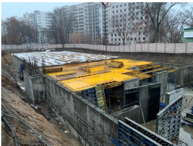
Будівництво підземної школи на базі ліцею № 105.
