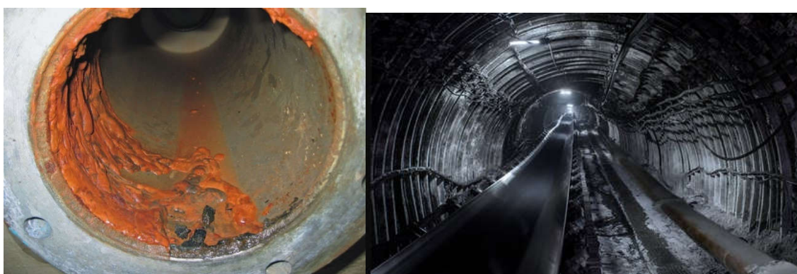
Рисунок 1 - Коррозия внутренней стенки шахтного газопровода
