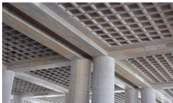
Рисунок 1 – Вид залізобетонного кесонного перекриття
